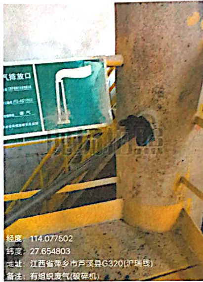
石灰石破碎废气排气筒出口
